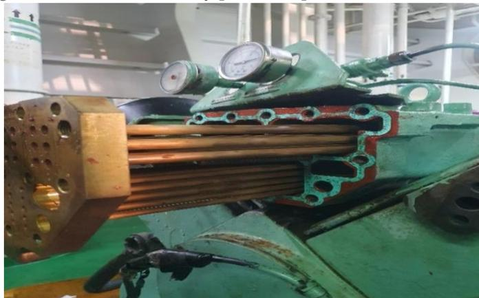
**Gambar 18. Penggantian tubenest assembly pada kompresor**
