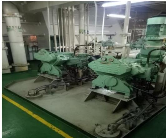
**Gambar 14. Kompresor udara hatlapa Hamworthy V-line 150**
