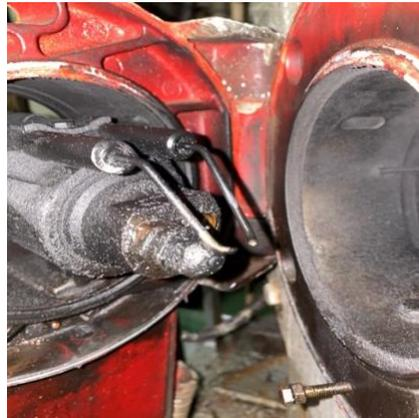
Gambar. 5 Nozzle Burner Boiler Sebelum Dibersihkan
