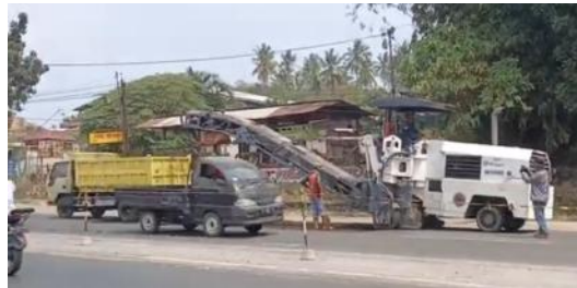
Gambar 1. Galian Aspal Hot Mix (AHM) menggunakan Alat Cold Milling Machine (CMM).
