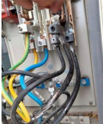
Gambar2. Pelepasan cincin kabel JTRYang Ada Didalam Kotak PHB-TR
