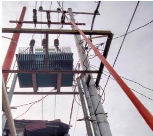
**Gambar 4.** Pelepasan FCO Dari LBS Menggunakan Telescopic Hot Stick
