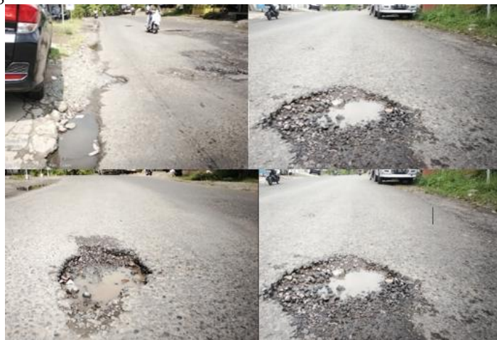
Gambar 2. Kerusakan Jalan dilapangan
